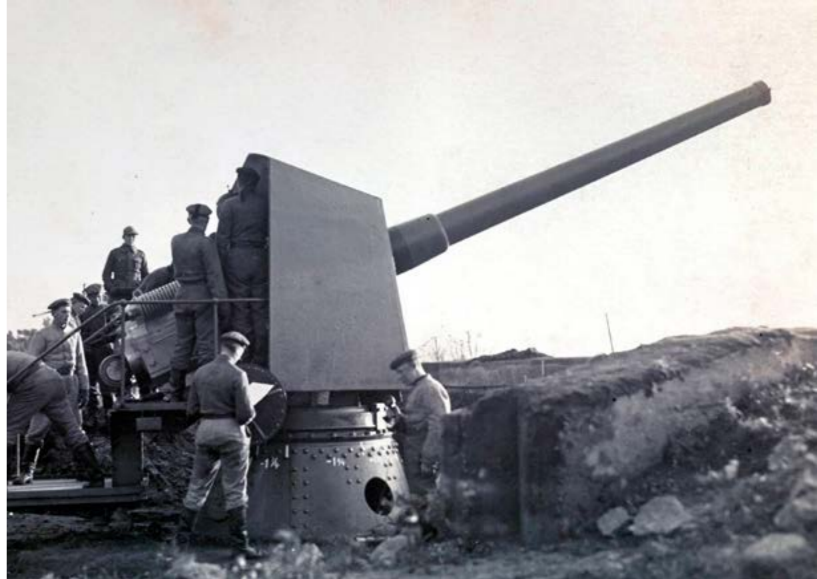
Erityisen merkittävää oli raskaiden 152/45-C tykkien kehitystyö, jonka avulla kaluston käyttöarvo moninkertaistui. Korotusmahdollisuuksien parantamiseksi tykin kehto käännettiin siirtämällä tykin alapuolella oleva joustolaite tykin päälle. Tykin kääntäminen edellytti tykin varustamista painontasaimilla, palauttimen vahvistamista ja lavettirakenteiden uudistamista. Uuden lavetin ja tykin kääntämisen myötä saavutettiin huomattavasti suurempi korotuskulma. Kuva: SA-kuva
