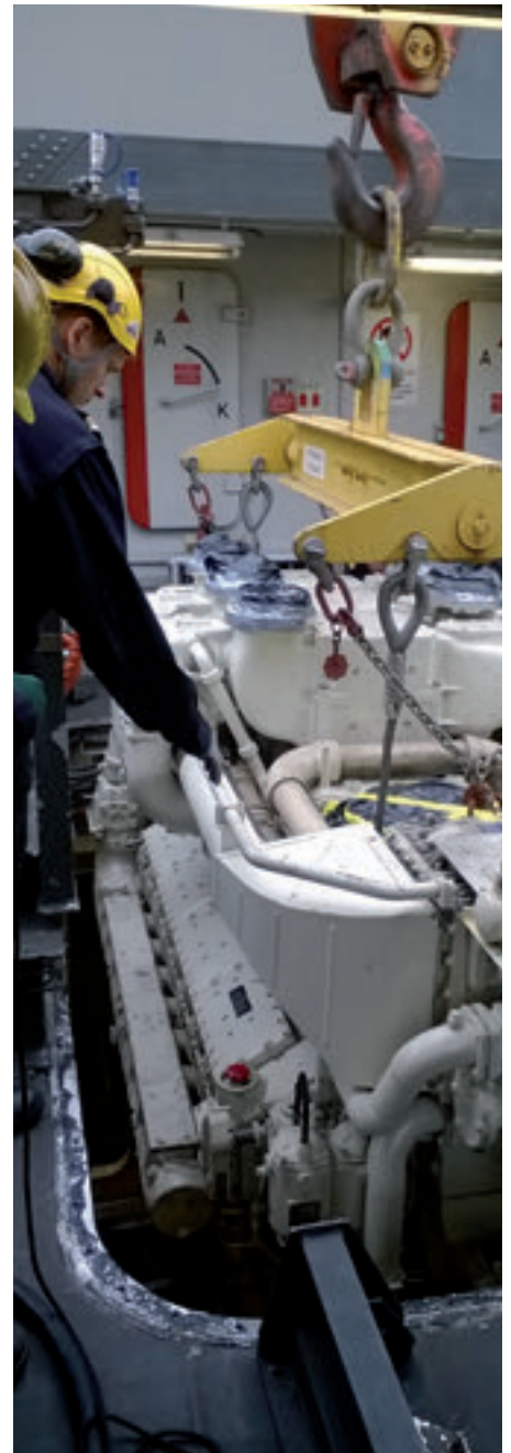
Ohjusvene Haminan pääkoneen nosto kapeasta luukusta vaati tarkkuutta.
